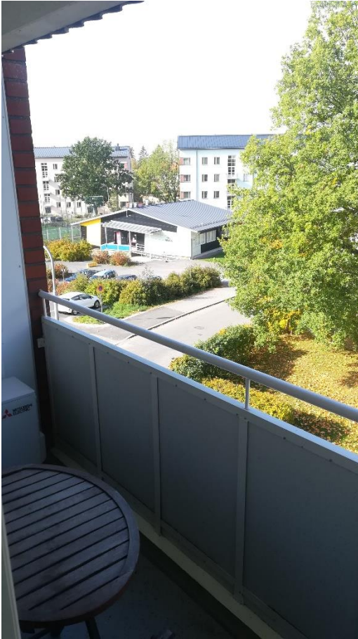
Kuva 3. Yleiskuva parvekkeesta, jossa ei ole parvekelaseja.
