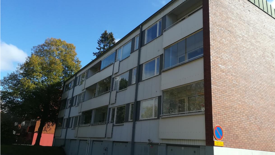
Kuva 1. Parvekkeiden puoleinen julkisivu. Osa parvekkeista lasitettuja.
